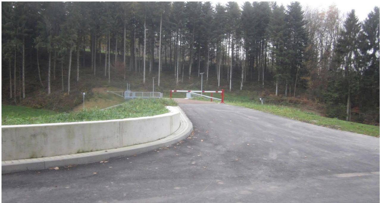
Abbildung 16: Dammauffahrt und Schutzmauer im Freibordbereich am Beispiel HRB Diersburg
